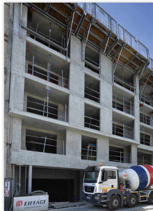
Réseau en dallage du parking
