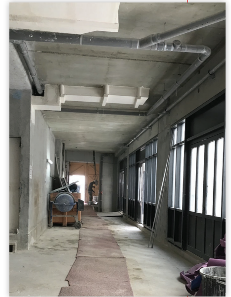
Verrière en cours de construction
